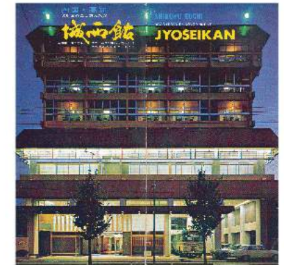
増改築により8階建となる(昭和43年頃)
