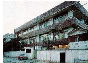
別館が完成する(昭和38年) 旧水道町(現在の城西館の裏側)から 撮影されたものと思われる
